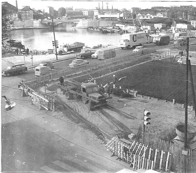
PHOTOGRAPHIE de PIERRE DOUZENZEL OCTOBRE 1963 Le bassin de la Gare Carrée, pendant les travaux de construction de l'autoroute. Vue prise de l'Avenue Wilson, au sud de l'écluse • FIGURE 33 •
