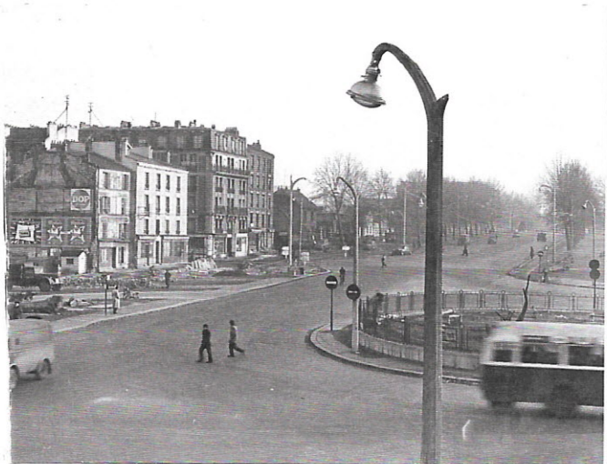
PHOTOGRAPHIE de PIERRE DOUZENZEL FEVRIER 1956 Le rond-point de la Porte de Paris Vue prise de la Rue Gabriel Péri, en regardant vers l'Avenue Wilson • FIGURE 28 •
